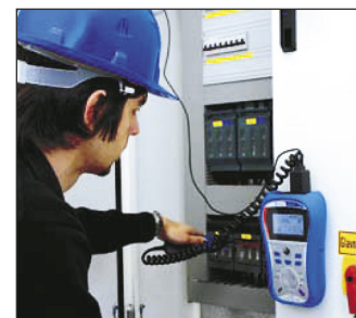
Un dispositif d'accrochage astucieux qui permet de travailler "mains libres"
